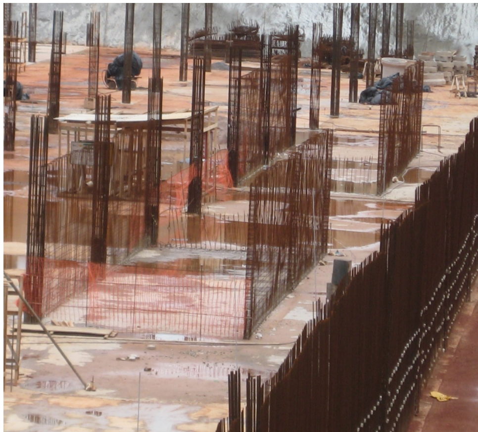
Foto 4 – Armação de pilares
