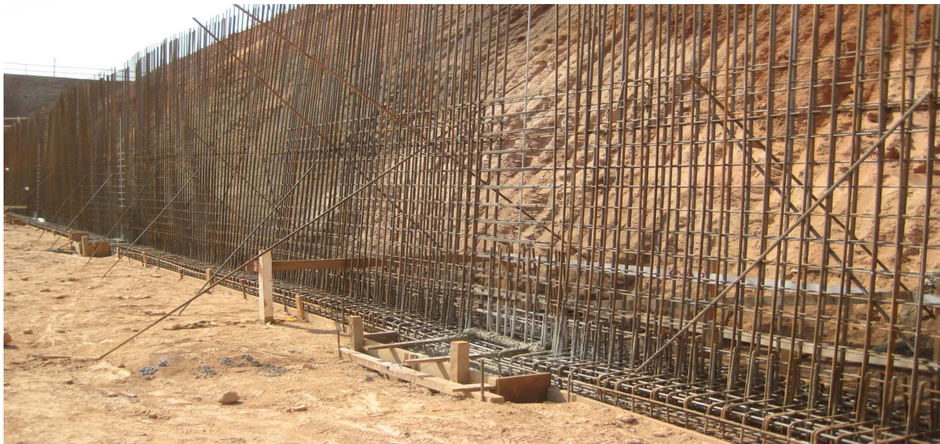
Foto 2 –Execução de vigas de fundação da cortina eixo 14
