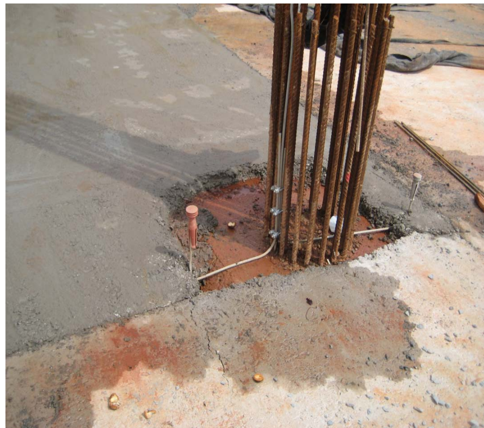
Foto 10 – Aterramento e proteção contra descargas atmosféricas
