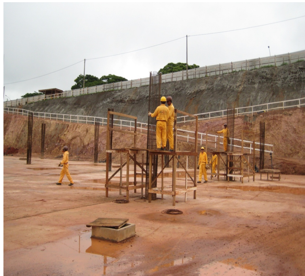
Foto 5 – Armação de pilares
