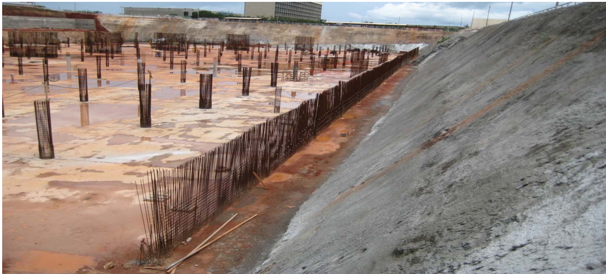
Foto 8 – Armação cortina Eixo 14
